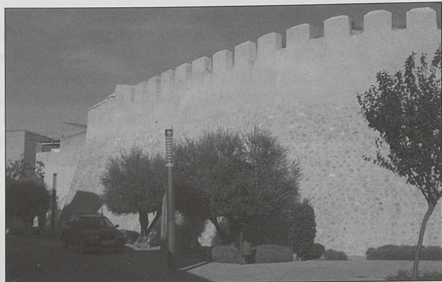
Muros restaurados del castillo de Caudete
