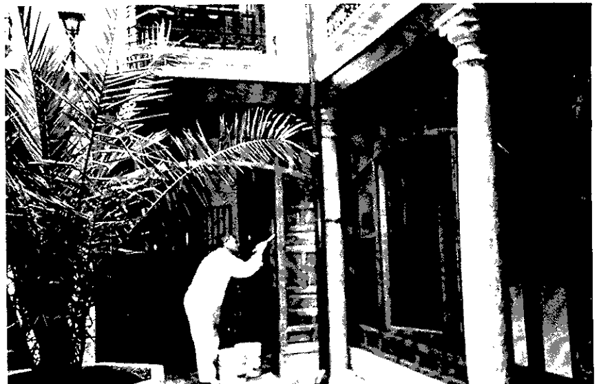
Obras del nuevo "Convento"
