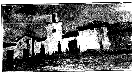
Villatoya.--Un pintoresco rincón de la patriarcal villa.
