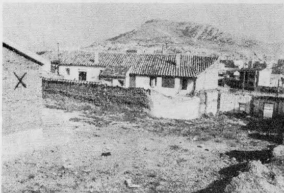
Pueden verse los peligrosos cerramientos ruinosos alrededor de la Escuela (X)
