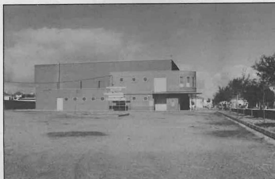
El Pabellón Cubierto, construido en terrenos de cesiones urbanísticas, ha incrementado nuestro patrimonio y cubierto muchas necesidades de nuestros jóvenes.
