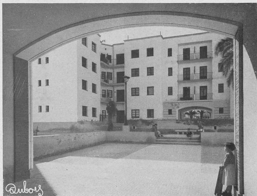
CADIZ.—Bloques de viviendas de San Severiano. Patio central del bloque núm. 1
