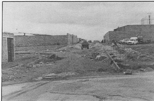
Obras prolongación calle Alhambra
