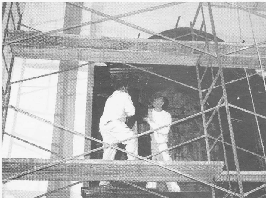
Obras de preparación del presbiterio.
