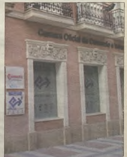
Fachada de la Cámara
