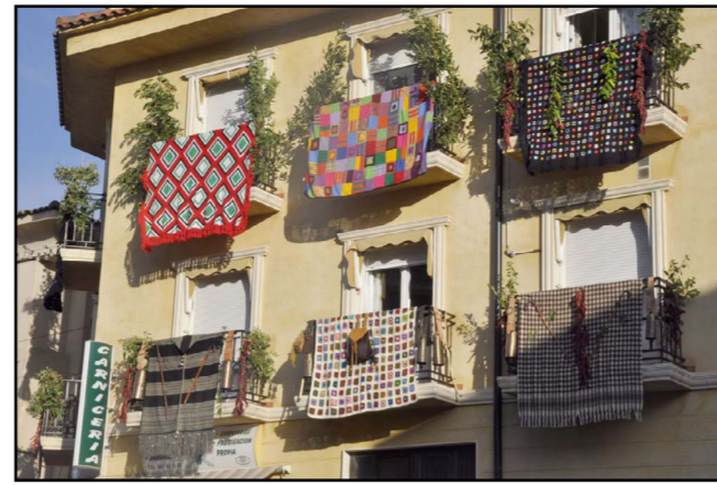
Fachada de la Calle Cava
