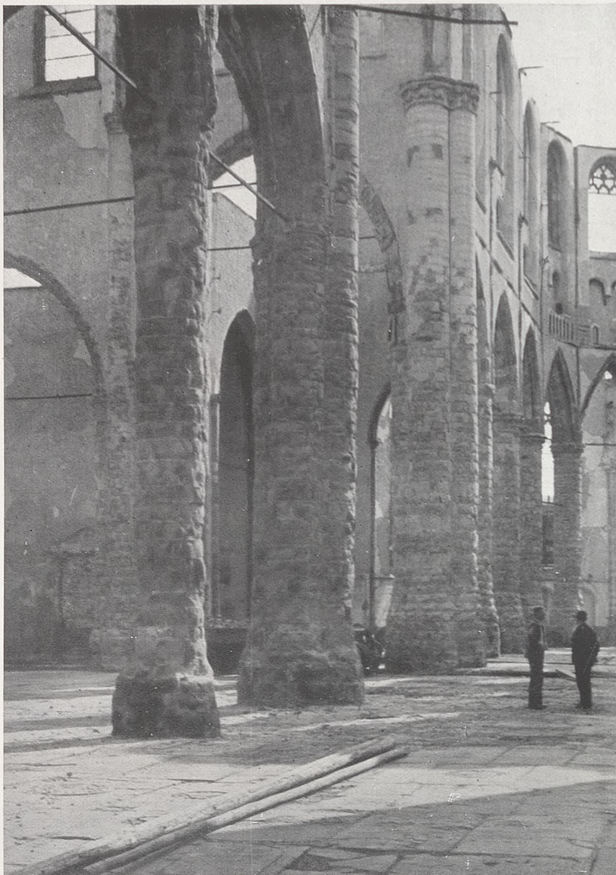
Interior de la Iglesia, destruida, de San Lo- renzo.
