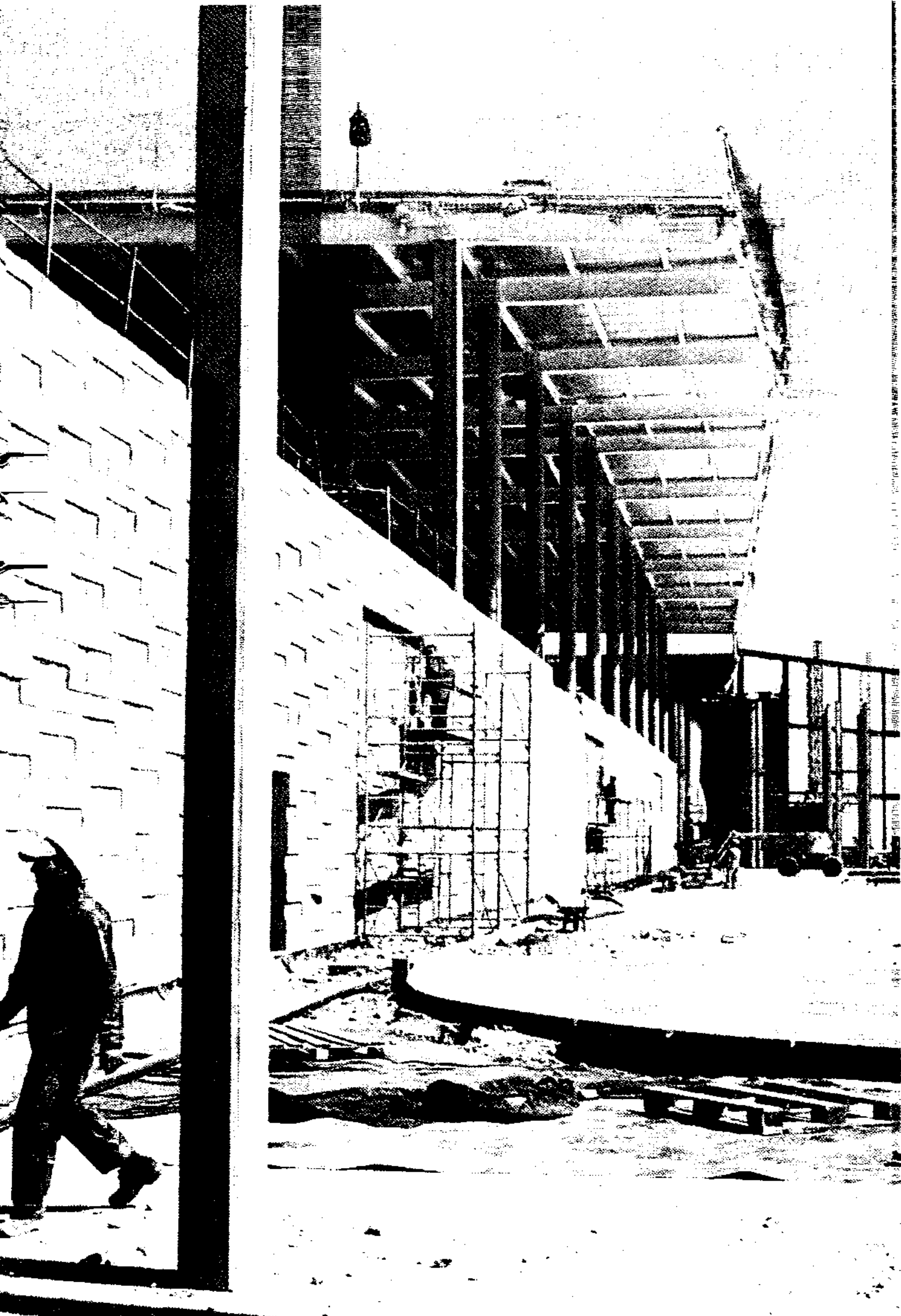
Las obras del centro comercial Luz de Tajo, en la capital regional, fueron realizadas por Peyber
