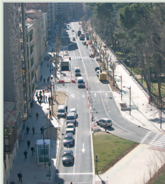
Primeros vehículos sobre el flamante asfalto.
