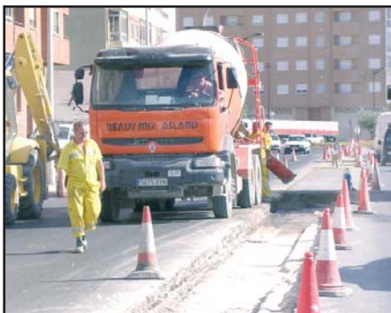
Imagen actual de las obras en Circunvalación.
