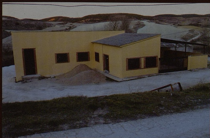
COGOLLUDO Reformas en el matadero municipal y antiguo almacén de trigo
