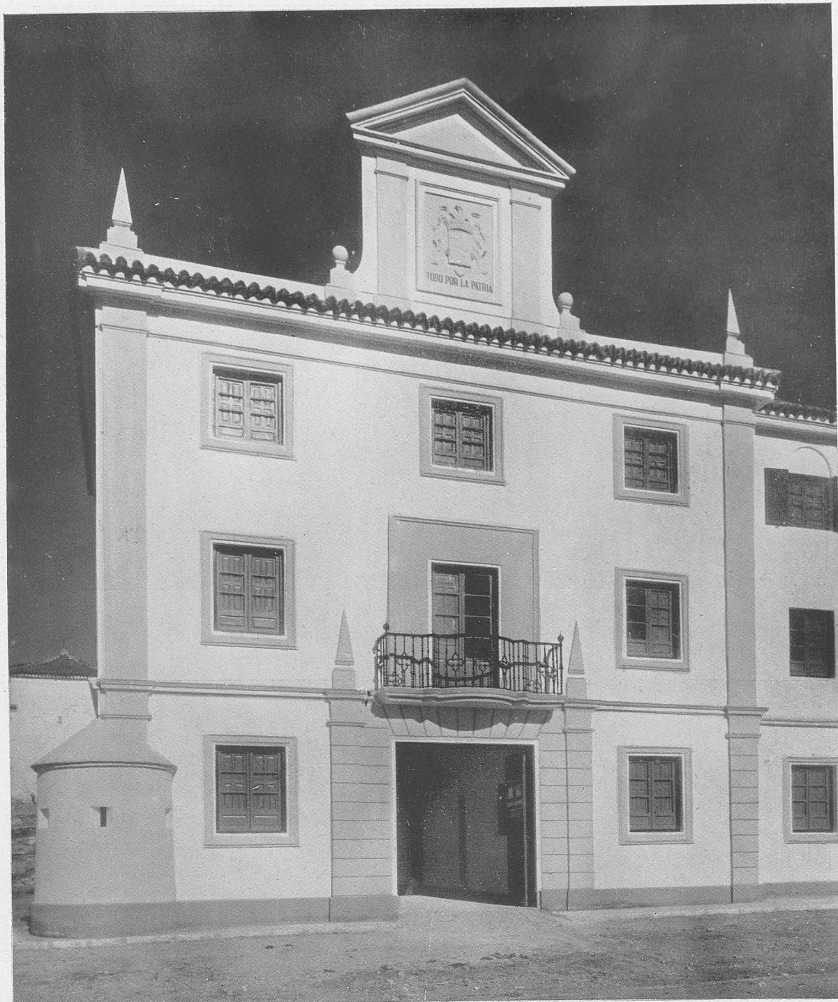
MOTRIL.—Cuartel para la Guardia Civil. Detalle de fachada.
