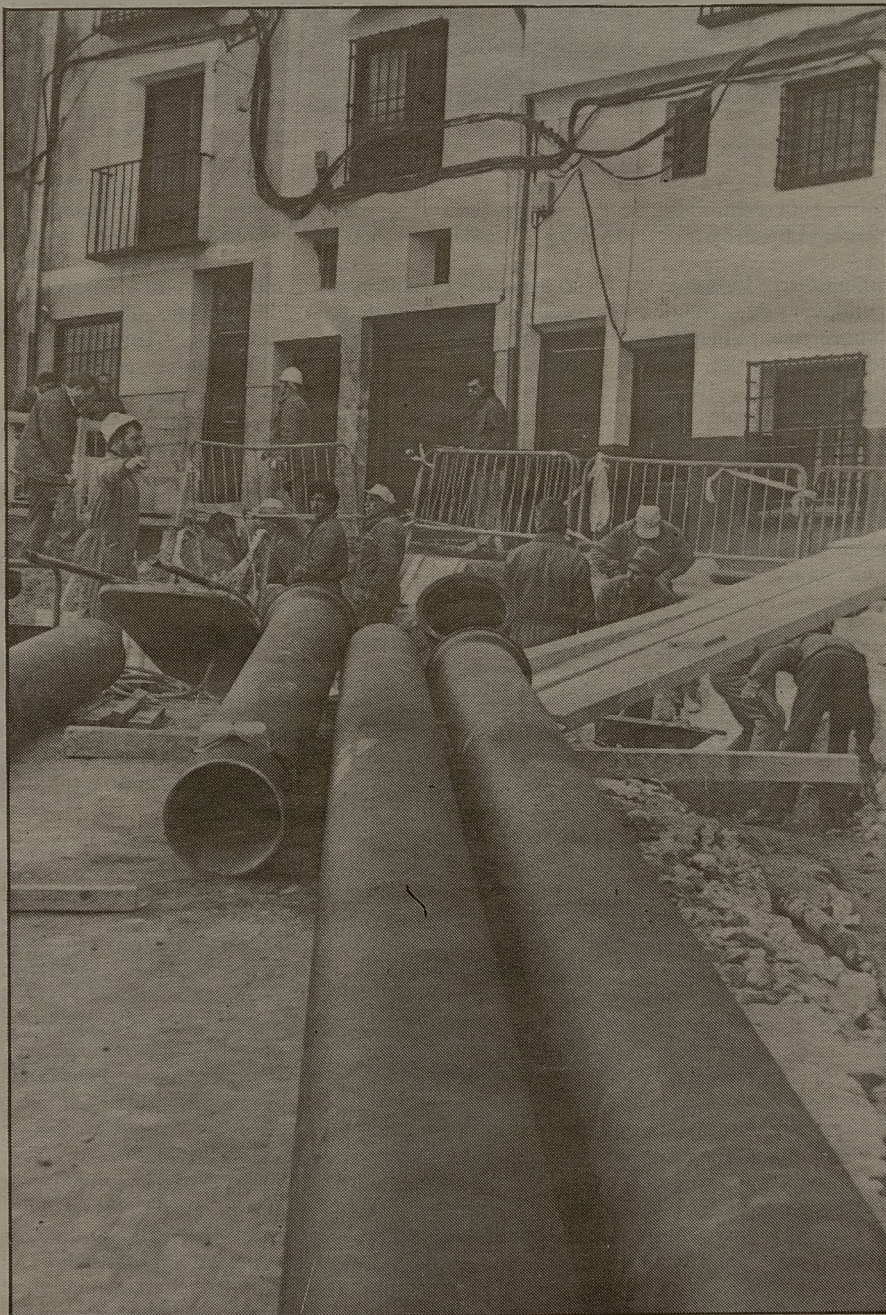
Las obras de infraestructura y remozamiento buscan mejorar la calidad de vida de los ciudadanos.
