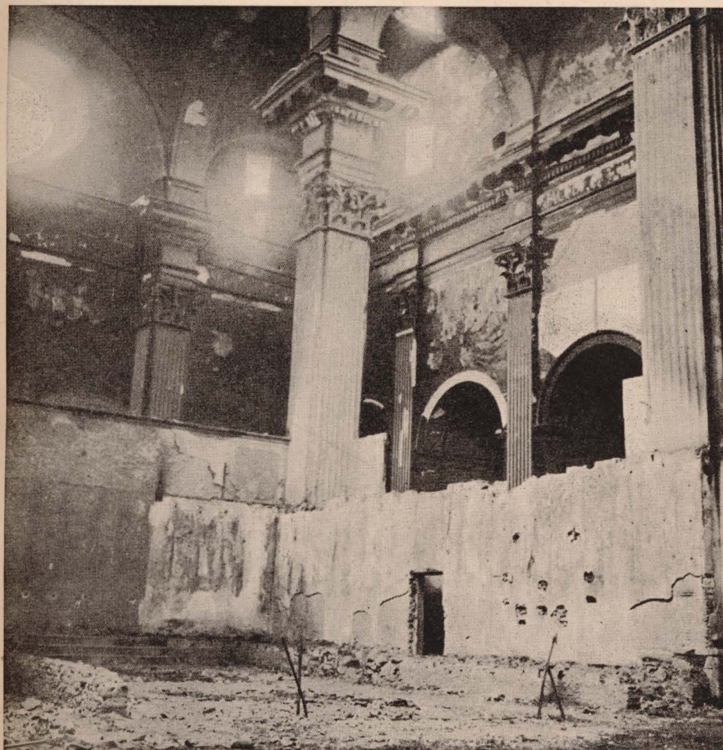
Recinto que ocupó la sillería del Coro. Paramento en el cual se hallaba construido el órgano. Fotografía obtenida en enero de 1937. Se aprecia el efecto de las llamas en la pared circundante.
