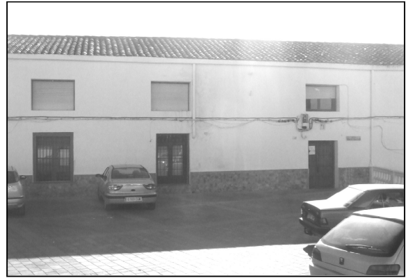
Edificio donde se ubicará el aula de la Fundación FISLEM
