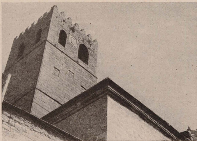
Reconstrucción: Esquina de la Contaduría, reparado.
