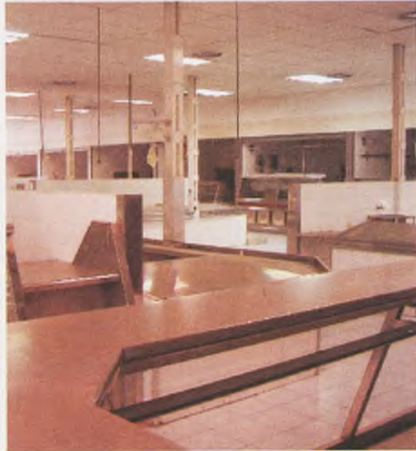
Desolador aspecto del Mercado Municipal.
