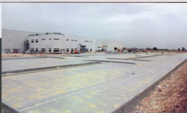
Instalaciones de Vestas a un mes de su apertura
