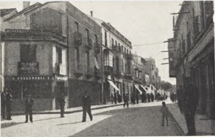
Una vista de la misma calle anterior, tomada en nuestros días. Por obra y gracia del trabajo y ejemplaridad de sus hijos. Tomelloso ha pasado, de su primitiva condición de aldea, a su actual estado de ciudad moderna. (Foto Muñoz.)
