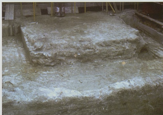
Figura 4. Torreón del frente norte de la muralla del Alcázar. Obsérvese la obra original de hormigón encofrado y el forro posterior.
