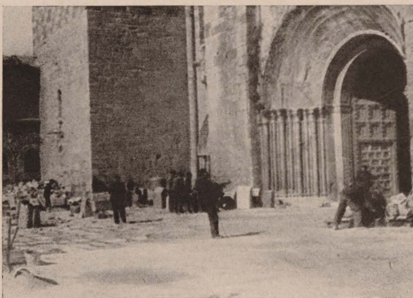
Reconstrucción: Fachada Oeste, en pleno trabajo.
