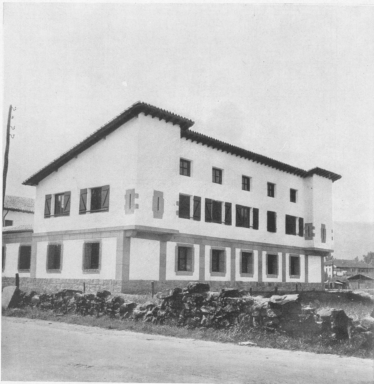
AMOREBIETA.—Casa cuartel para la Guardia Civil. Fachada lateral.
