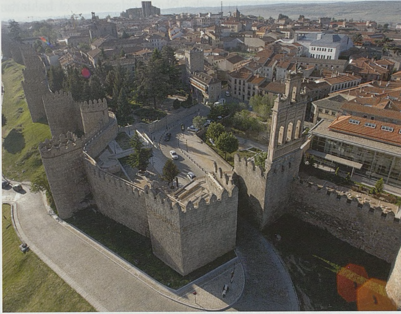
Figura 14. Vista aérea de la Puerta del Carmen
