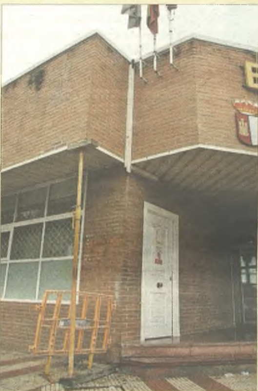
> La Estación apenas se sujeta con puntales.
