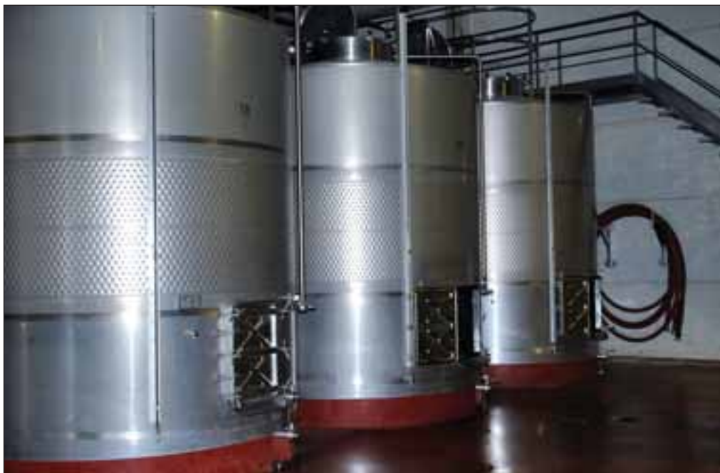
Equipada con los más modernos avances técnicos, la bodega posee una instalación de selección y clasificación de la uva junto a depósitos de fermentación controlada de 15.000 y de 20.000 litros.
