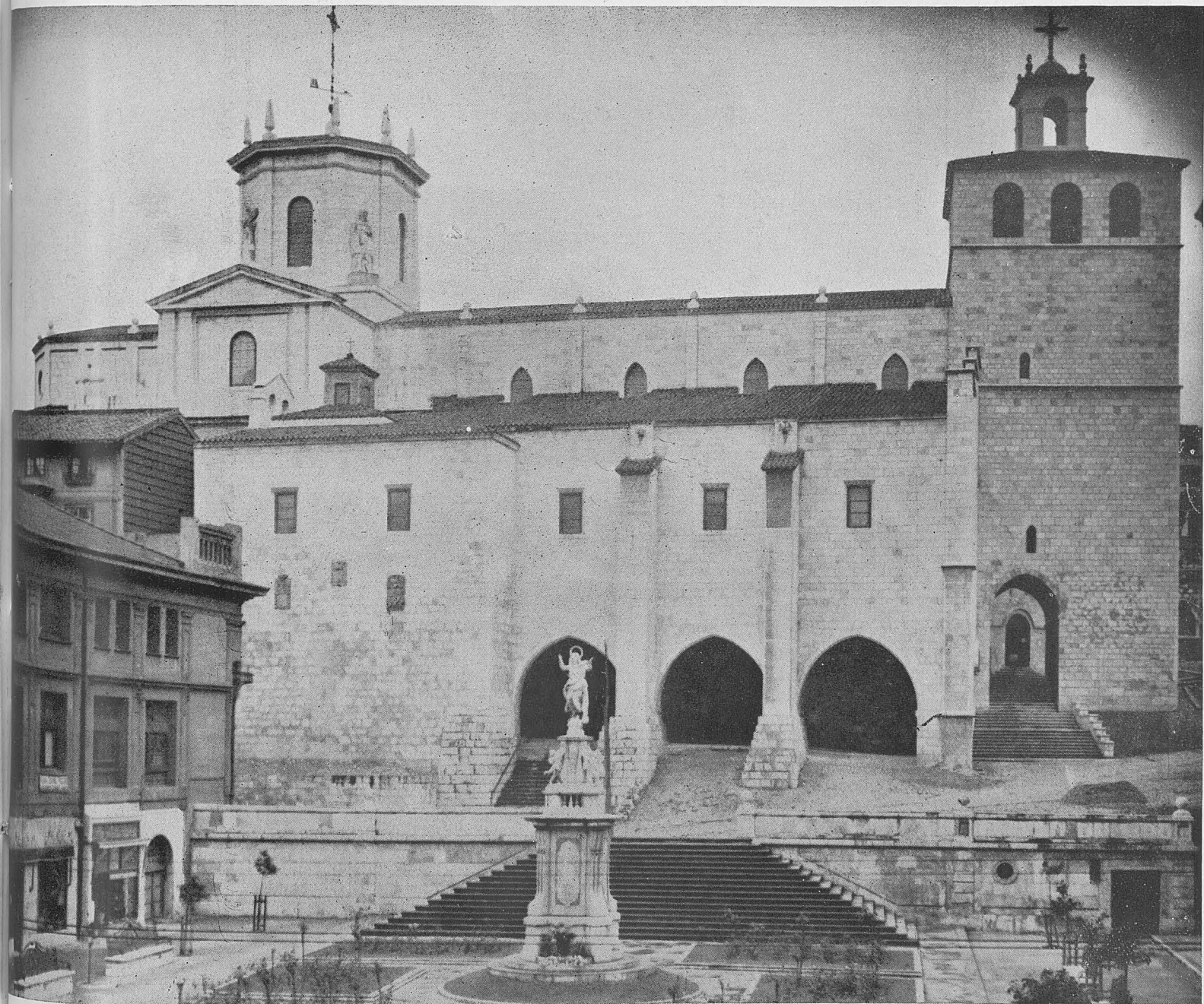
SANTANDER.—Catedral. Fachada Norte reconstruída.
