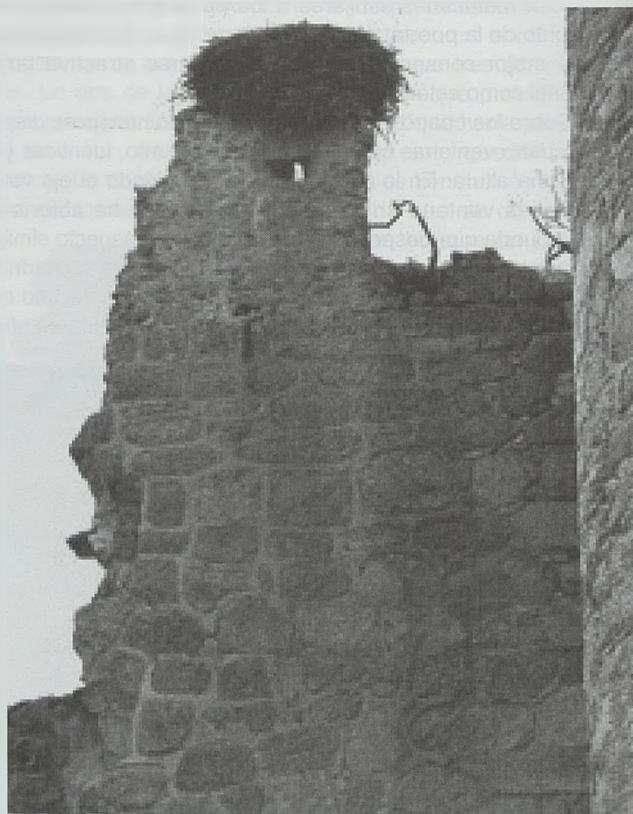
Tronera de buzón en un paramento de la muralla Norte
