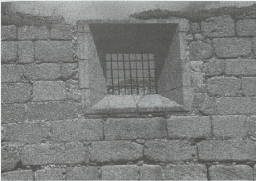
Ventana abocinada del siglo XVI situada en el muro Sur de la fortaleza
