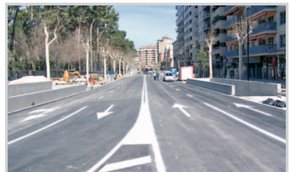
El antes y el después de las obras de la Avda. de España.
