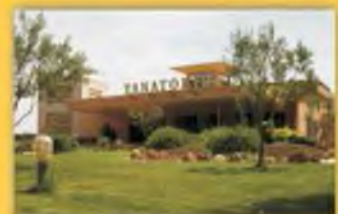
Zona Ajardinada Amplios Aparcamientos
