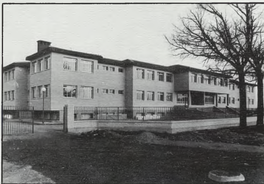
Centro regional de trabajo para minusválidos psíquicos (en construcción por EDIPSA)
