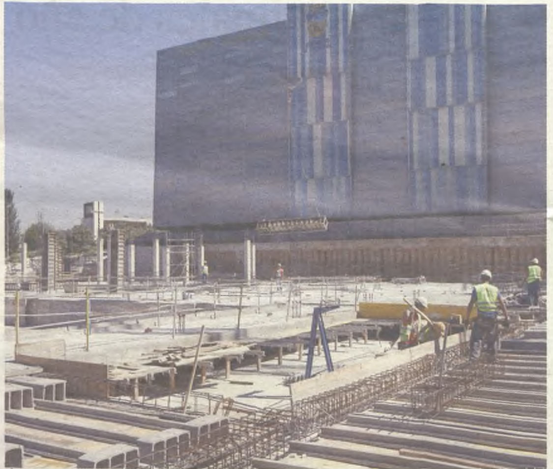
Ya se ha completado la fase de cimentación./J.Ropero
