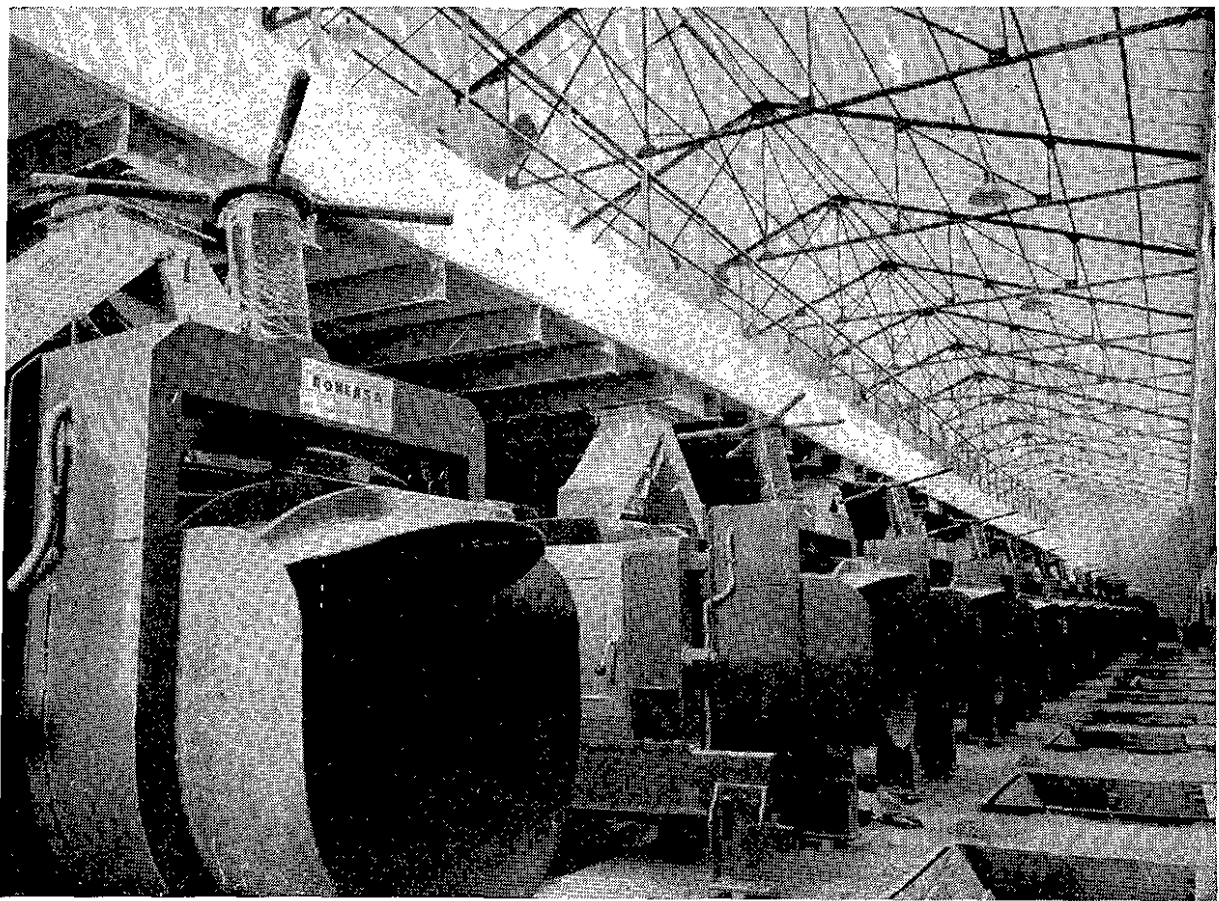
IMPRESIONANTE ASPECTO DE LA NAVE DE PENSADO
