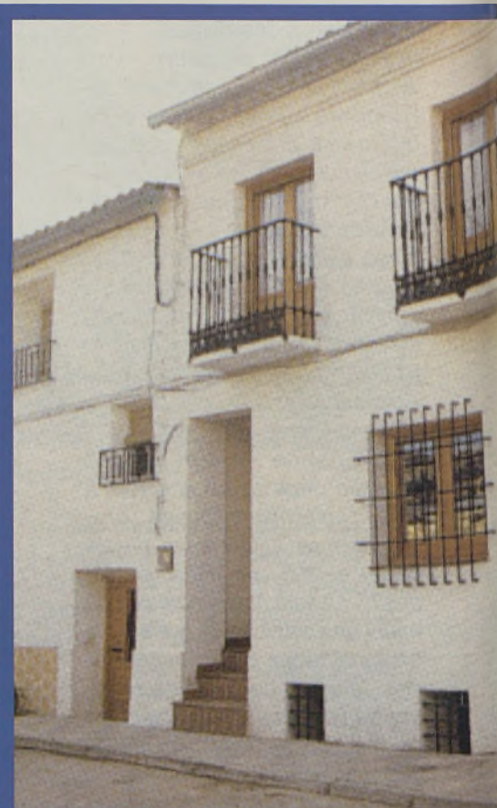
Recientemente se construyeron chalets adosados en Aguas Nuevas, pero no fue suficiente para cubrir las necesidades de la localidad
