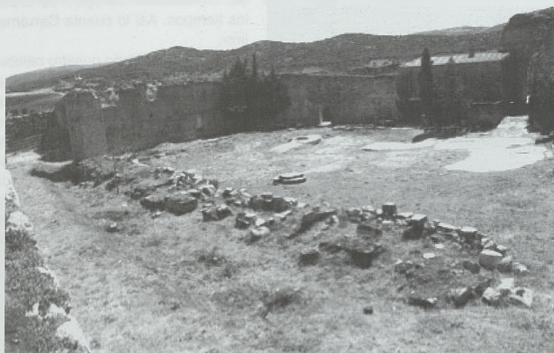
Ruinas y despojos de las dependencias domésticas palaciegas del siglo XV y de las reformas posteriores
