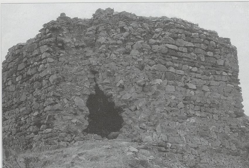
Foto nº 4 Torre con alcíbe (torre g) del alcázar de Montemayor
