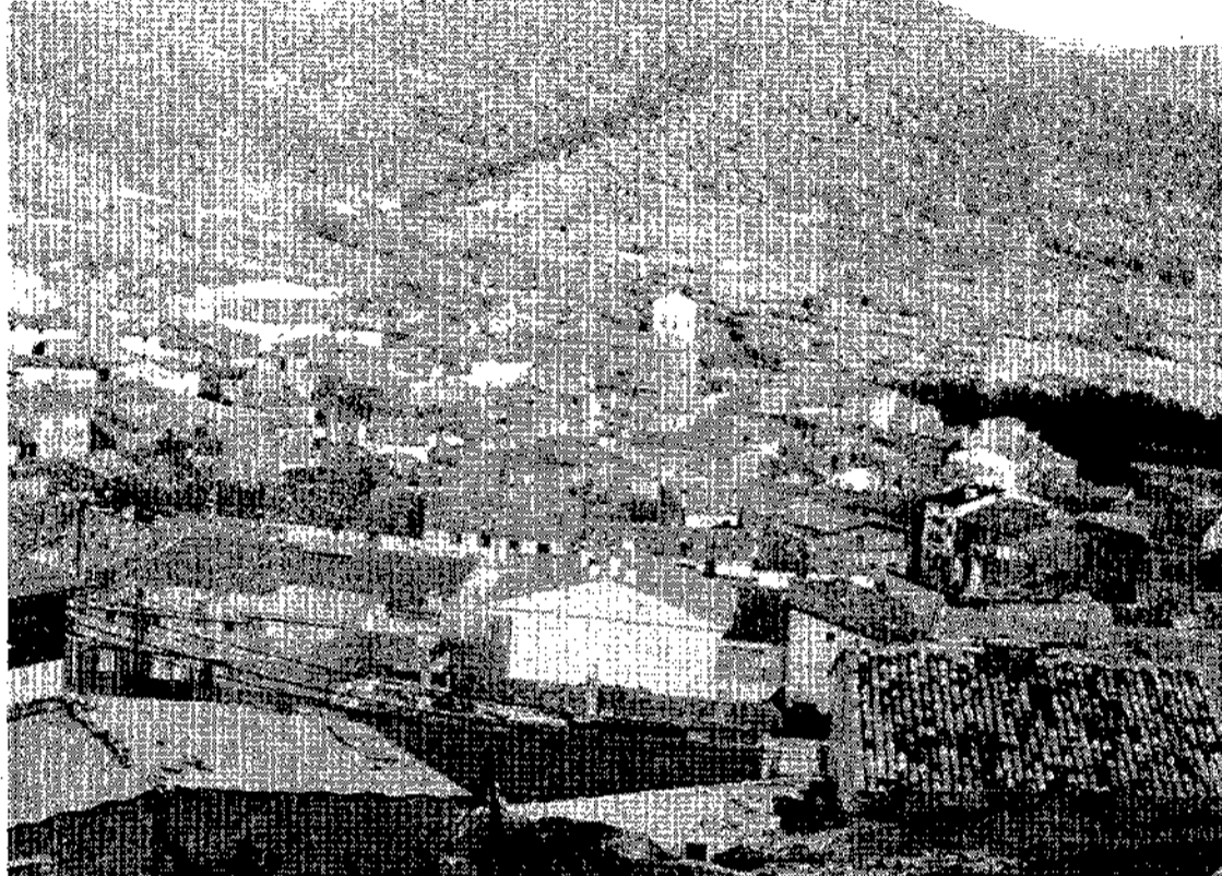
Vista general de Villar del Humo
