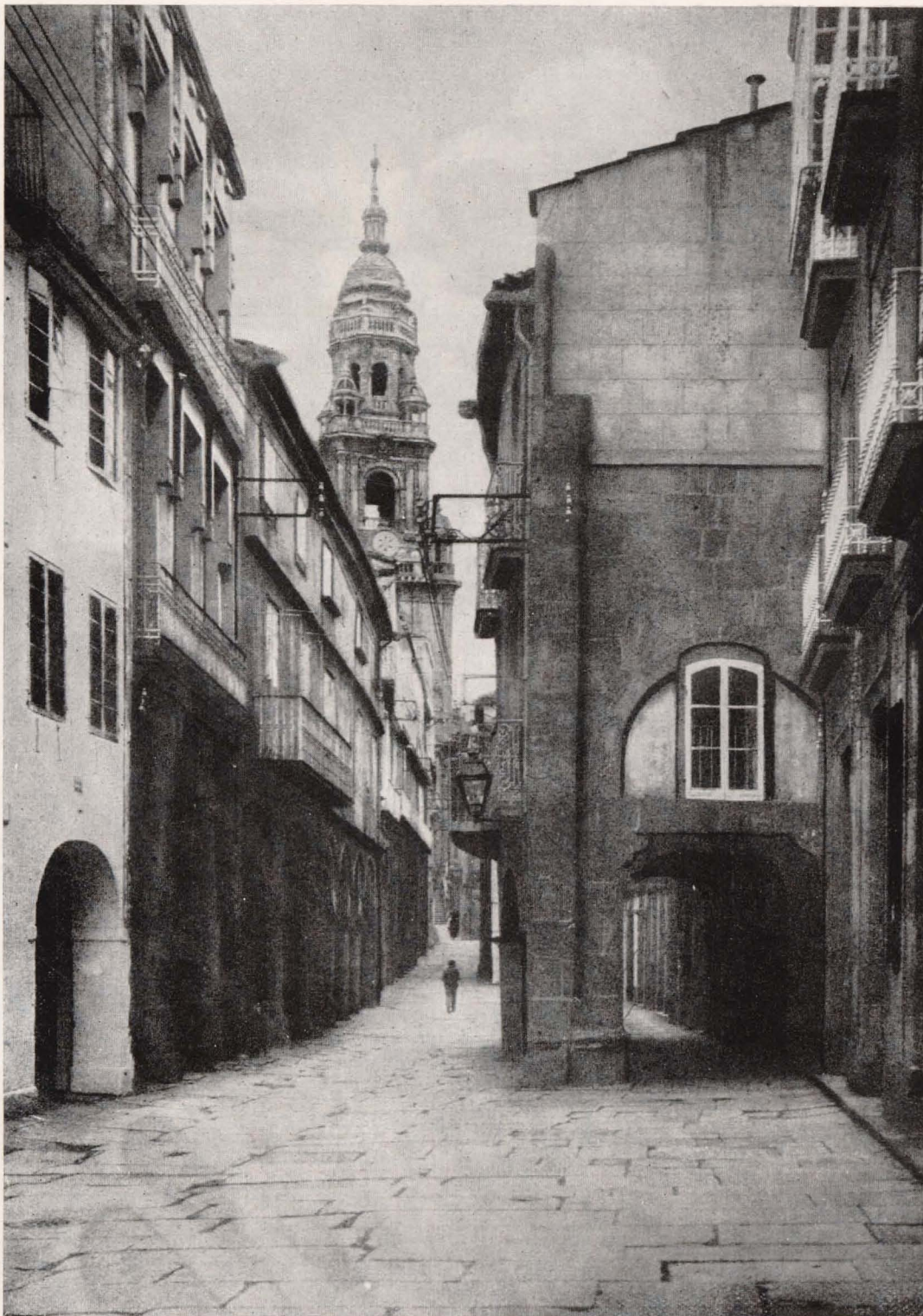
SANTIAGO DE COMPOSTELA.—Rúa del Villar.
