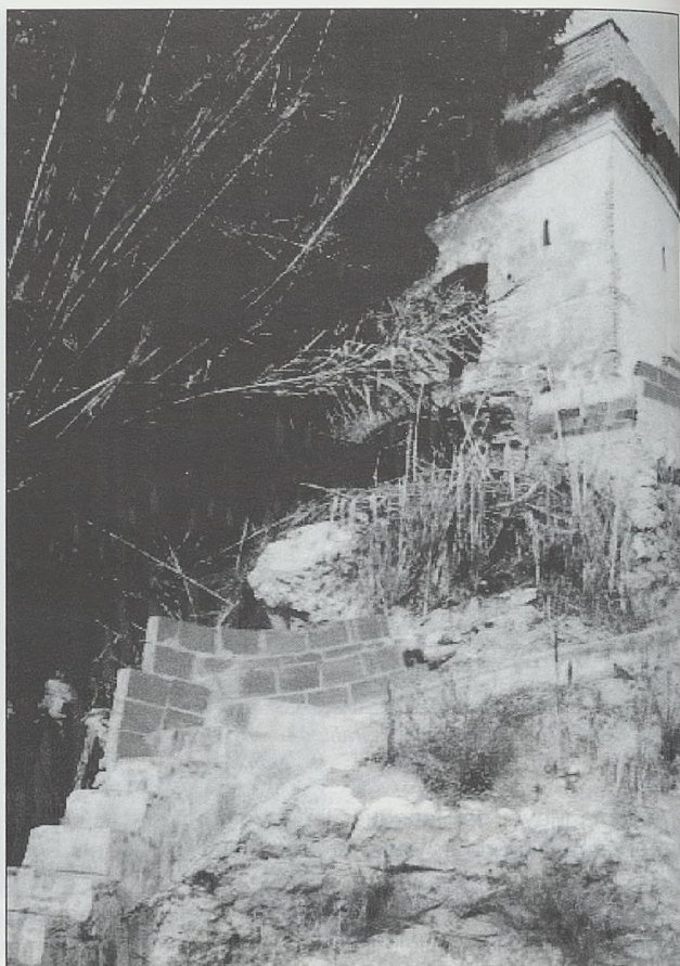
Fig. 17. Fachada de la Almenara hacia poniente
