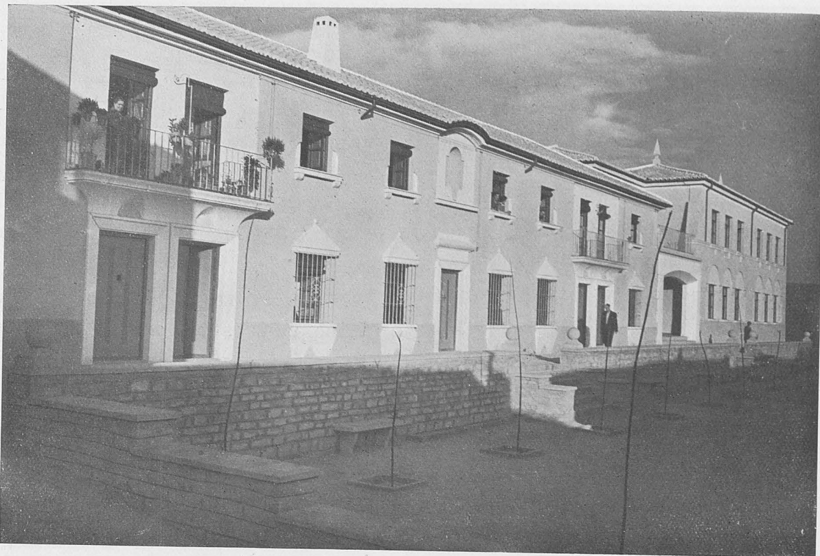
ARJONA.—Grupo Escolar y viviendas para maestros.
