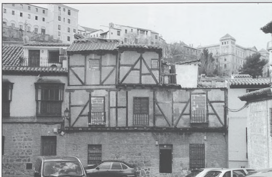
La Junta de Castilla-La Mancha aporta ayudas extraordinarias que incluyen pagar una parte del proyecto de obra, la dirección de la obra o la memoria de ejecución.
