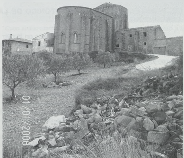
Vista del recinto conventual de Aberin. Ábside de la iglesia y flanco oriental del monasterio. Talud amurallado y plataforma
