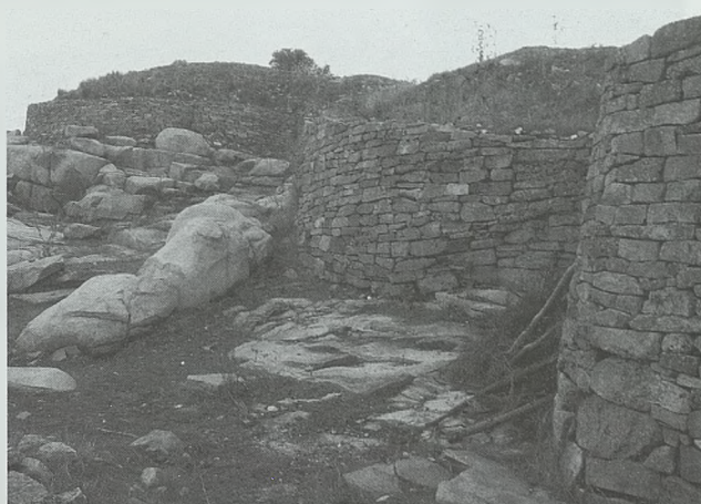
Detalle del lienzo principal de Las Cogotas, bien adaptado a la topografía del terreno
