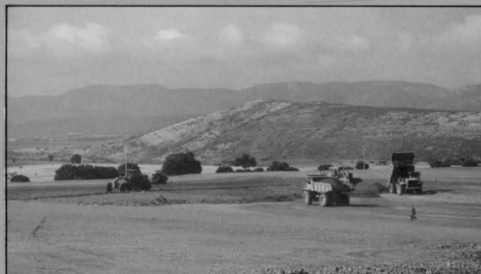
Prosigue la explanación y se han instalado los edificios de dirección
