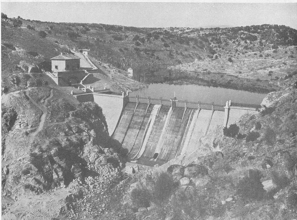
Vista general de la presa y embalse.
