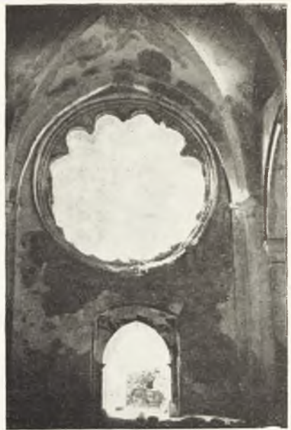
Interior del monasterio de Calatrava la Nueva.
